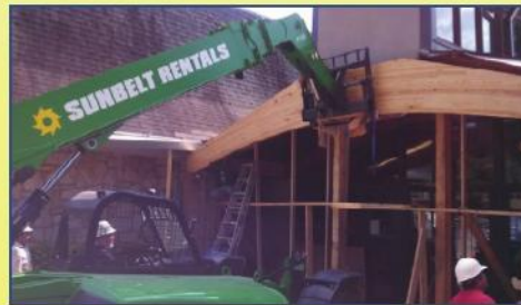
Installation of beam: Entrance of our Main Sanctuary Instalación de viga en la entrada de la iglesia
